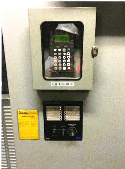
Photo 43: AHU1 VFD
